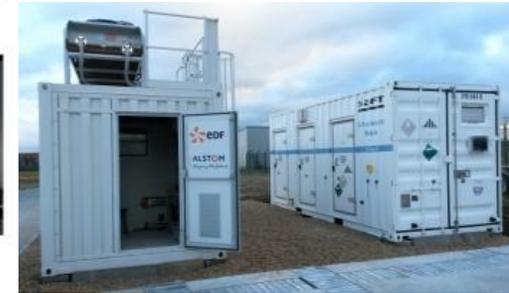
**1 batterie = plusieurs modules + 1 système de gestion électrique + gestion thermique...**
