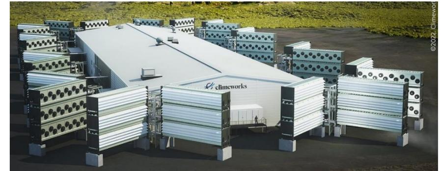
Consommation énergétique : 2 GJ<sub>élec</sub>/tCO<sub>2</sub> – 11 GJ<sub>therm</sub>/tCO<sub>2</sub>
